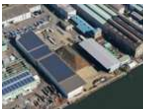
太陽光発電システムを備えた 川崎事業所
